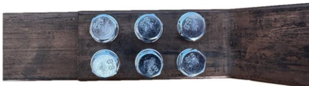
Рисунок 4 – Соединенные медные шины
