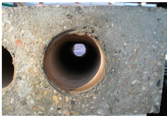
Рис. 5 – Фрагмент железобетонного монолитного пустотного перекрытия
