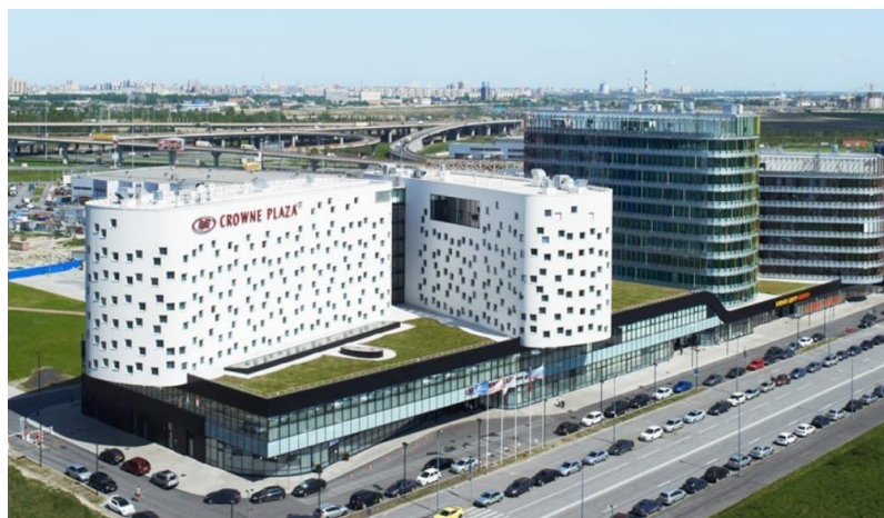
Рисунок 7 - Здание аэропорта «Пулково» в Санкт-Петербурге.
