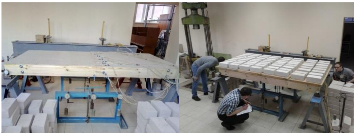
Рисунок 1 –Опытные конструкции до и во время испытаний
