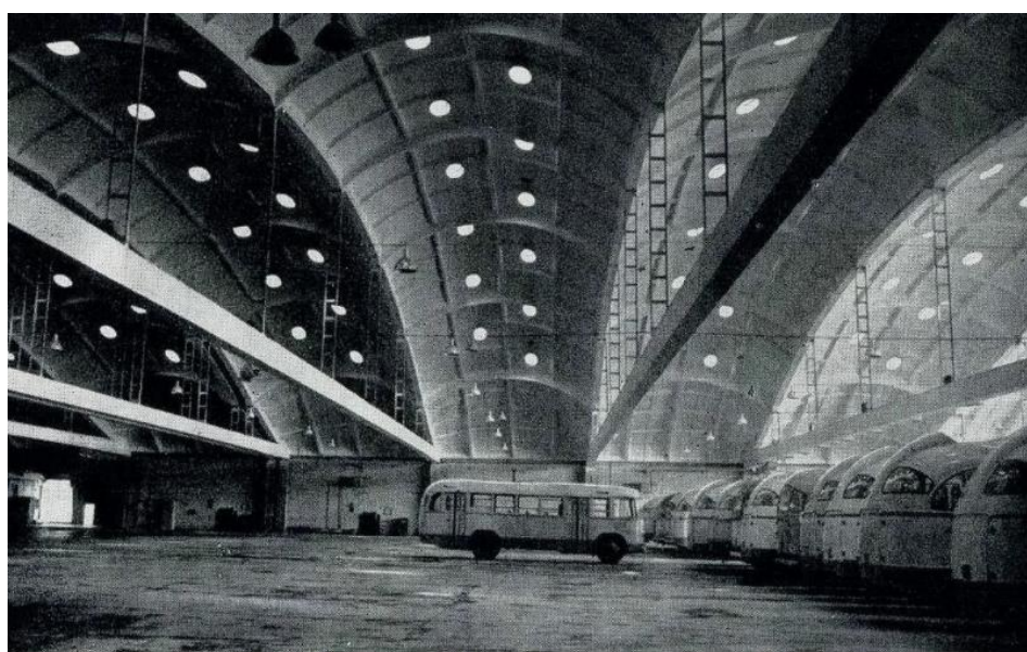
Рисунок 3 – Сборное бочарное покрытие 5-го автобусного парка, г. Санкт-Петербург
