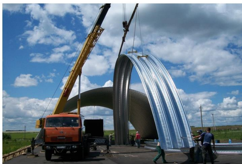
Рисунок 3 – Монтаж арочных оболочек
