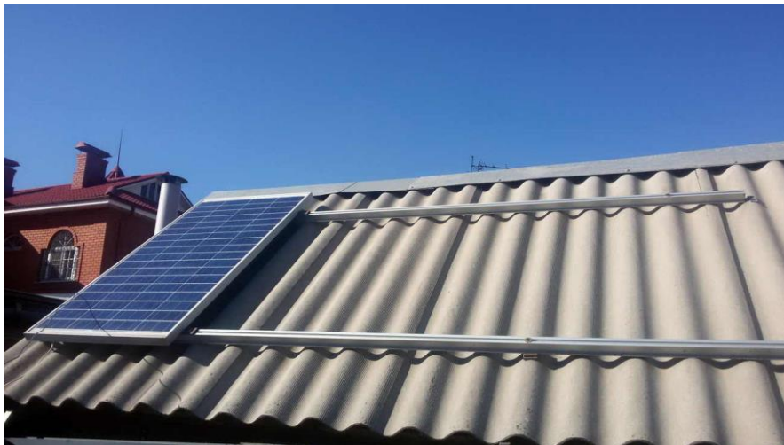
Рисунок 1- Пример крепления солнечных панелей
