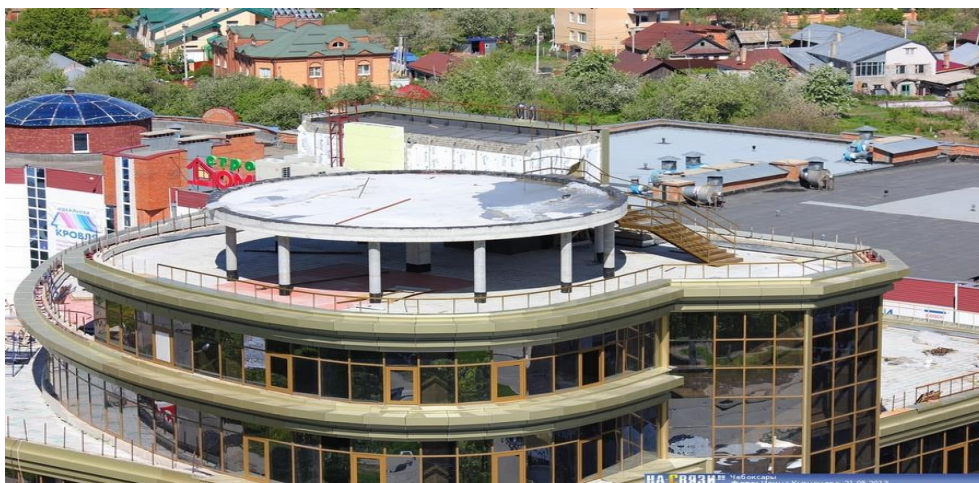
Рисунок 3 – Возведение вертолетной площадки с использованием трубобетонных конструкций
