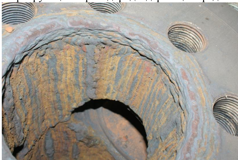
Рисунок 1 – Наплавленная внутренняя поверхность корпуса задвижки фонтанной арматуры
