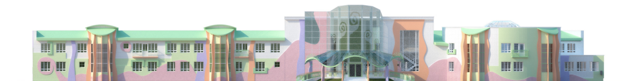
Рисунок 1 – Главный фасад реабилитационного центра по ул. Немовская
