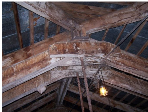
Рисунок 1 – Общий вид учебного корпуса №1 ОГУ и конькового узла стропильных ферм покрытия на момент проведения обследования в 2006 году
