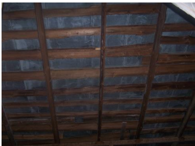
Рисунок 2 – Общий вид обрешётки и на деревянных стропильных ферм покрытия
