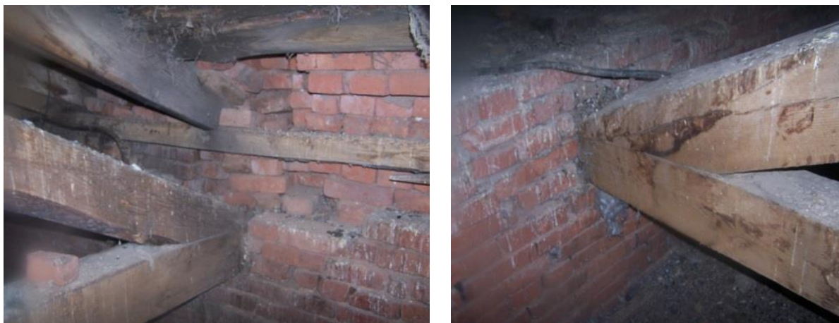
Рисунок 3 – Узел опирания ферм на кирпичные стены
