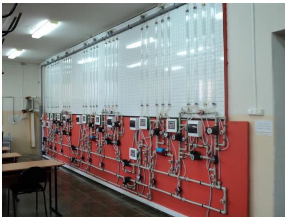
Рисунок 2 – Общий вид стенда по изучению гидравлических режимов тепловых сетей
