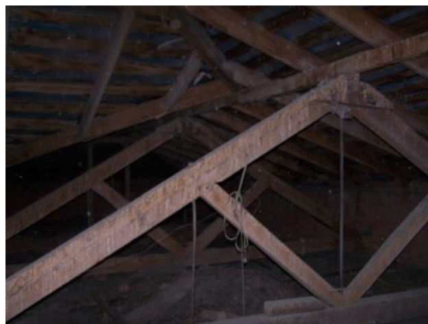
Рисунок 2 – Общий вид обрешётки и на деревянных стропильных ферм покрытия
