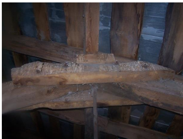
Рисунок 4 – Конструктивное решение конькового узла стропильной фермы
