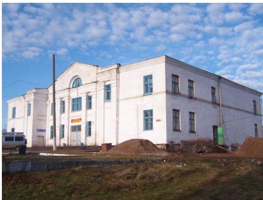
Рисунок 1 – Общий вид районного дома культуры на момент проведения обследования
