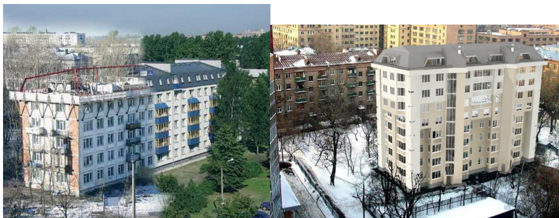
Рис.2 Примеры капитального ремонта в Москве.
